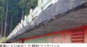
凍害により劣化した鋼筋コンクリート床版橋
