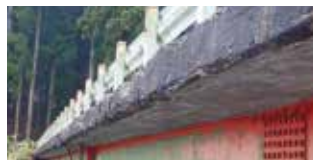
凍害により劣化した鋼桁コンクリート床版橋
