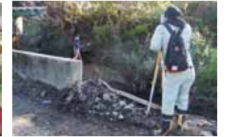
光波測距儀を使用した河川横断測量の様子
