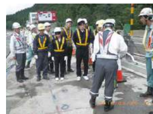
橋梁補修現場の見学風景
